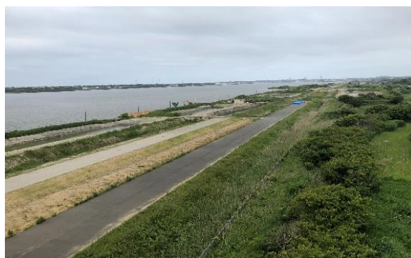
国道 356 号 銚子バイパス (銚子市)
