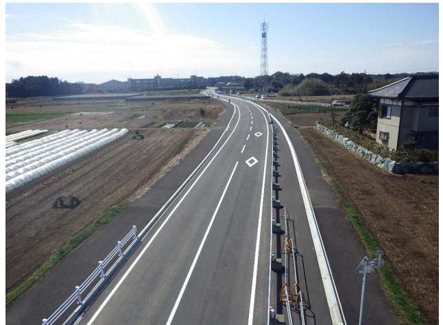
県道下総橋停車場東城線（東庄町） 開通区間
