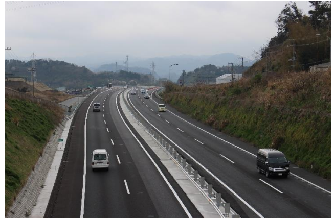
館山自動車道（富津市湊地区） ※令和2年3月 4車線化運用開始
