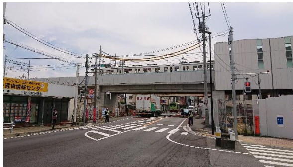
東武野田線（野田市） 高架化後
