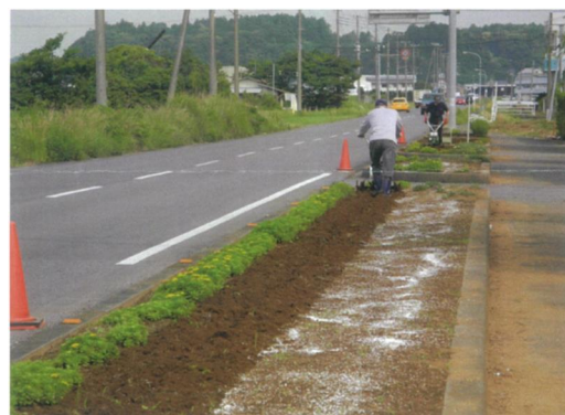
道路の清掃・美化活動状況 国道 296 号（匝瑳市）
