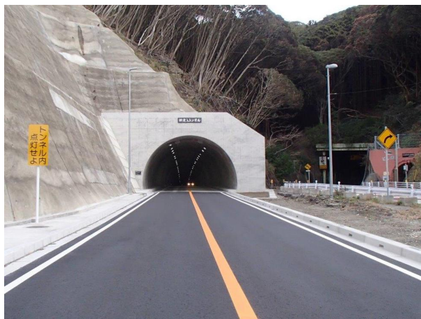
新実入トンネル（鴨川市）
