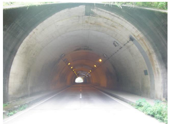
九十九トンネル（富津市）
