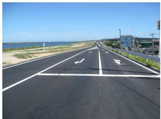
国道356号 小見川東庄バイパス（香取市）
