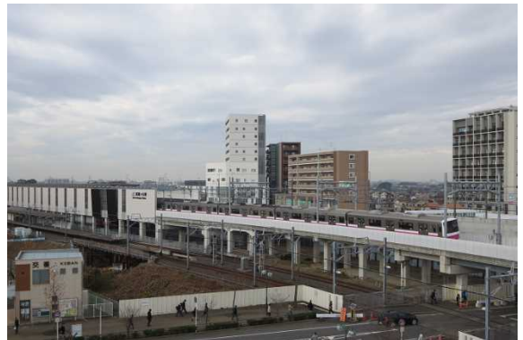
新京成線（鎌ヶ谷市） 全線高架化後
