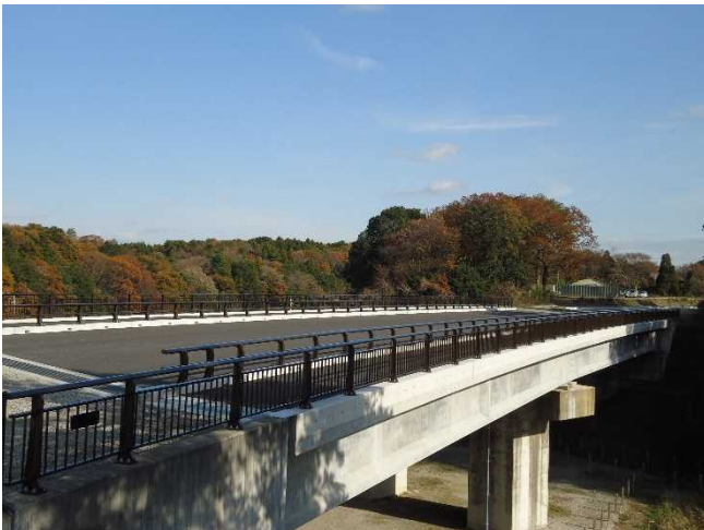
国道 296 号 八千代バイパス（八千代市）
