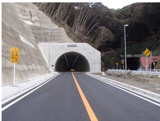
新実入トンネル（鴨川市）
