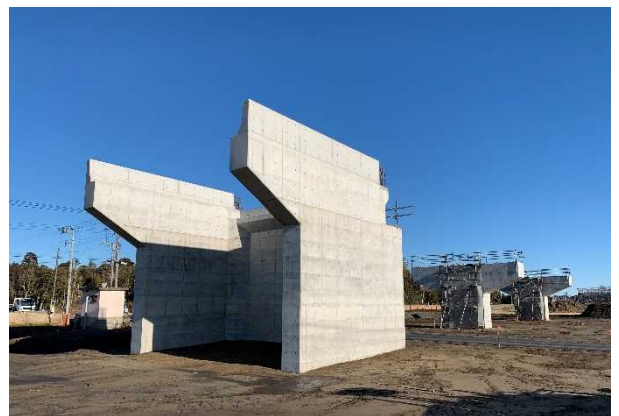
銚子連絡道路（匝瑳市）
