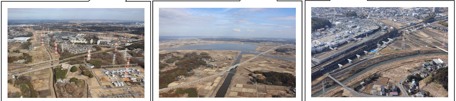
一般国道464号北千葉道路(市川市～成田市)
