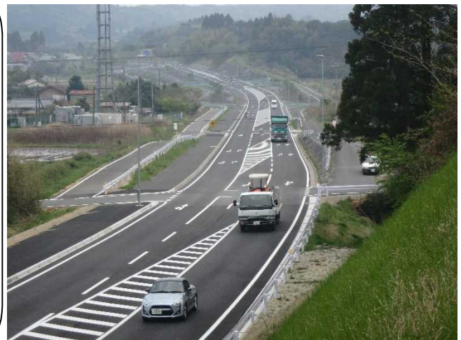
国道297号 松野バイパス開通区間(勝浦市)
