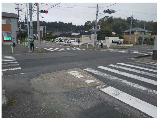
共同現地診断実施状況（山武市松尾町松尾）
