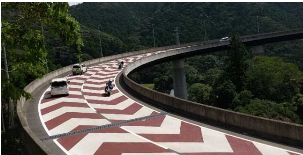
市原天津小湊線 坂本工区（鴨川市天津） 令和3年9月13日 開通
