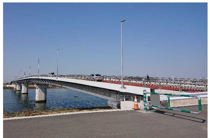
県道船橋行徳線 妙典橋（市川市）
