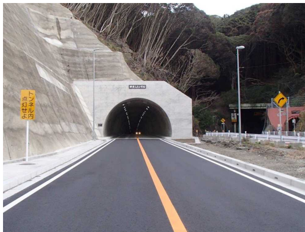
新実入トンネル（鴨川市）
