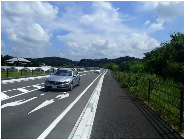
国道410号 久留里馬来田バイパス(君津市) 開通区間
