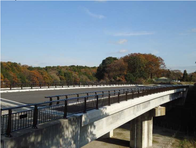
国道 296 号 八千代バイパス (八千代市)
