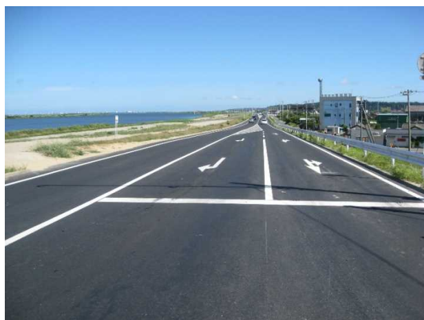
国道356号 小見川東庄バイパス（香取市）
