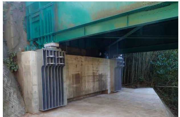
山田橋（印西市）
