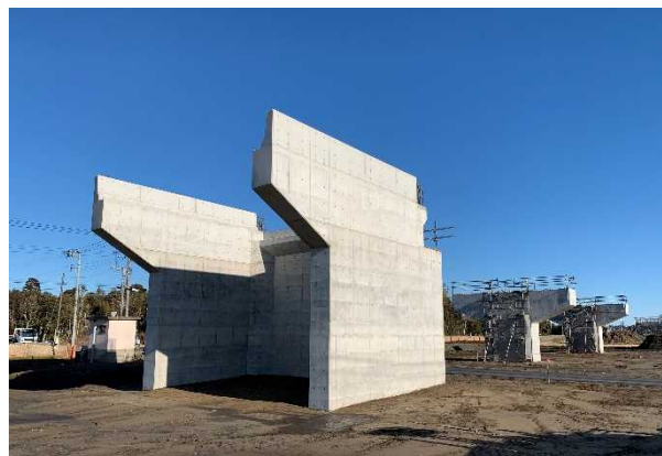
銚子連絡道路（匝瑳市）
