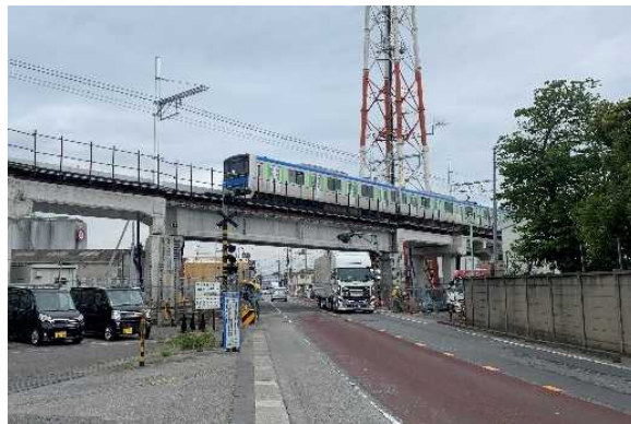
東武野田線（野田市） 高架化後
