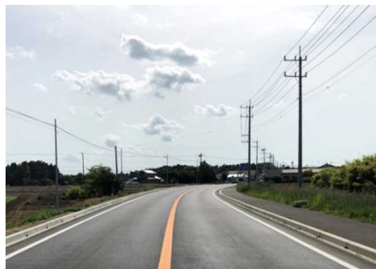
県道成田小見川鹿島港線（多古町十余三）
