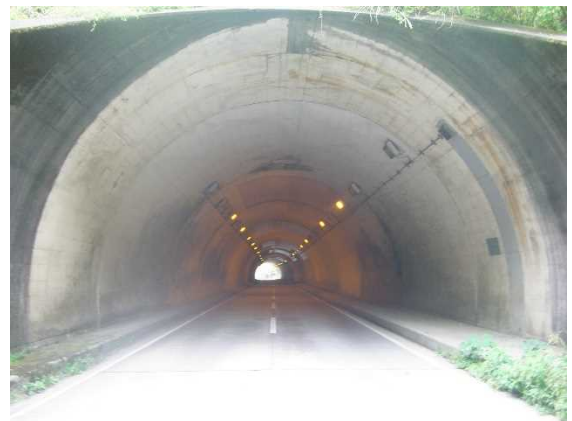
九十九トンネル（富津市）
