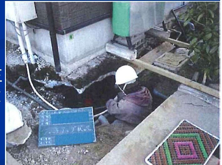
写真6 耐圧版工法によるジャッキアップ状況
