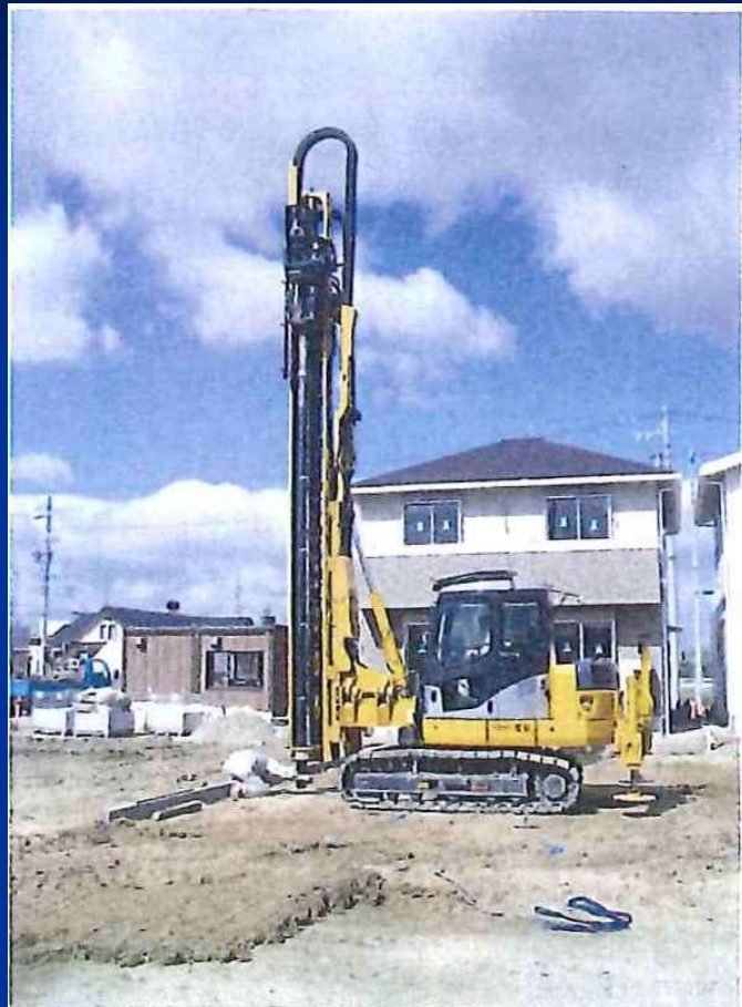
写真8 小口径鋼管杭の施工状況
