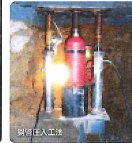
鋼管圧入工法
