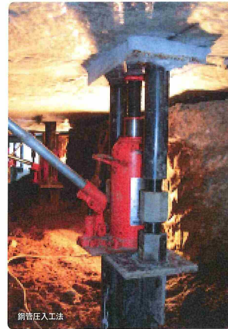
鋼管圧入工法
