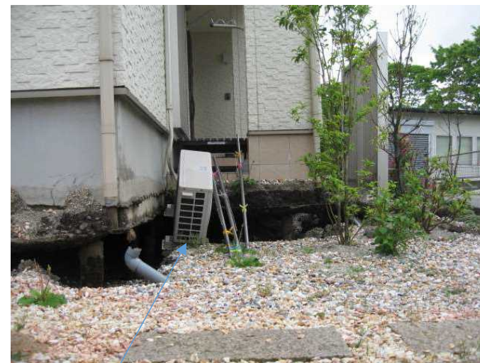
南側の基礎と地盤
