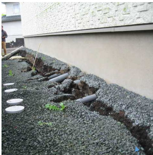
北側の基礎と地盤
