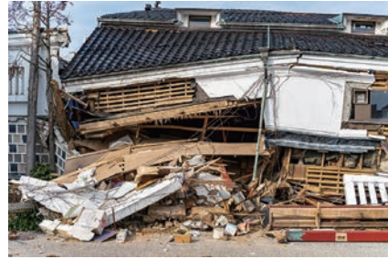
地震による被害例 (能登半島地震)
