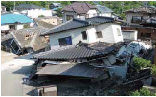
地震による被害例（熊本地震）
