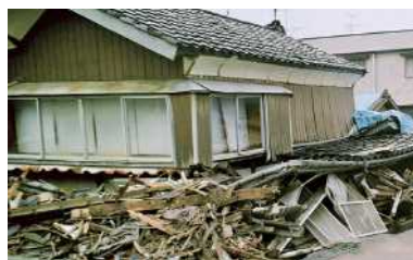
地震による被害例（新潟県中越後地震）
