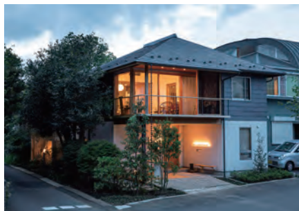
北面外観全景
