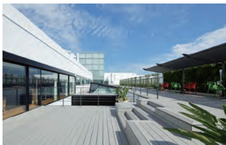
増築により生まれた屋上庭園は屋外での執務も可能となる
