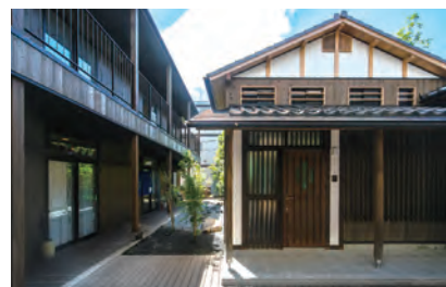
旧母屋復元 正面全景
