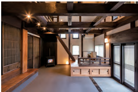
復元し吹き抜けとした玄関土間
