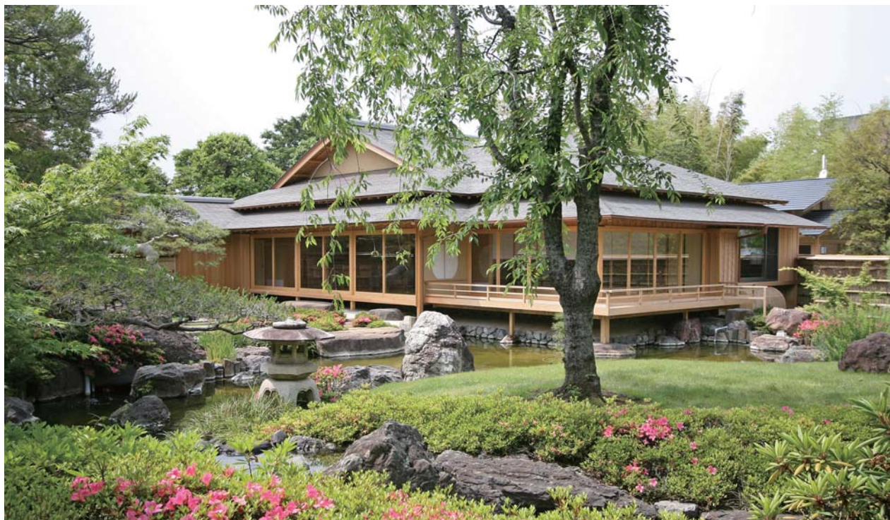
主庭からの全景 庭と馴染むように高さを整え、屋根を雁行させて動きを与えた。
