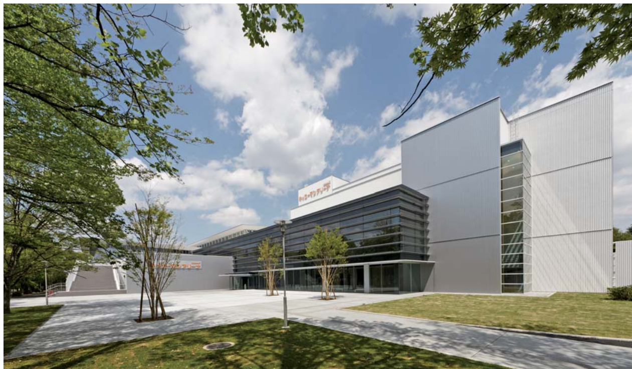
西側エントランスアプローチ 公園の森を抜けてエントランスへアクセス
