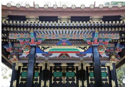
本殿 向拝：軒先および建具 銚金物 (銅製打出し、金箔押し)
