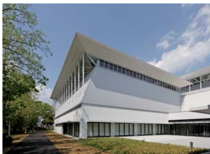
西側アリーナ外観 アリーナ内に自然光を採り入れる「く」の字型の外観
