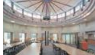
雇用促進事業団ポリテクセンター千葉研修寮(高齢者・障害者) 建築主: 雇用促進事業団千葉職業能力開発促進センター 設計: 株式会社榎本建築設計事務所 施工: 長谷工・青山建設共同企業体 所在地: 千葉市若葉区愛生町165-2
