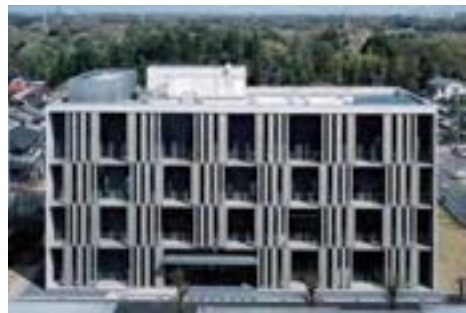
東京理科大学総合研究機構 光触媒国際研究センター(一般建築物)
