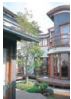
船橋の家(高齢者・障害者) 建築主：N氏 設計：株式会社アトリエCOSMOS 施工：株式会社南持井工務店 所在地：船橋市高根台
