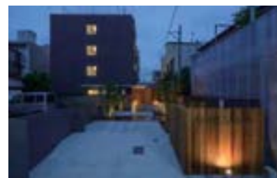
ソーシャルレジデンス船橋 (住宅/入賞) 撮影／山本 育憲 建築主：株式会社 オークハウス 設計：笠掛伸建築設計事務所 施工：株式会社ダイニチ 所在地：船橋市中山3-19-2
