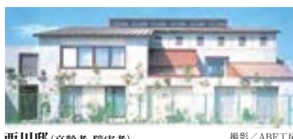
西川邸(高齢者・障害者) 撮影／ABE工房 建築主：N氏 設計：株式会社榎本建築設計事務所 施工：新日本建設(株) 所在地：市原市菊間
