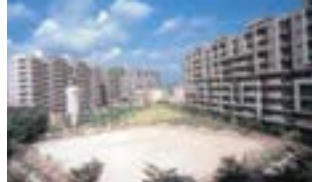
中銀ライフケア白井(高齢者・障害者) 建築主：中銀マンション(株) 設計：株式会社新居千秋都市建築設計 施工：株式会社フジタ東京支店 所在地：白井市堀込
