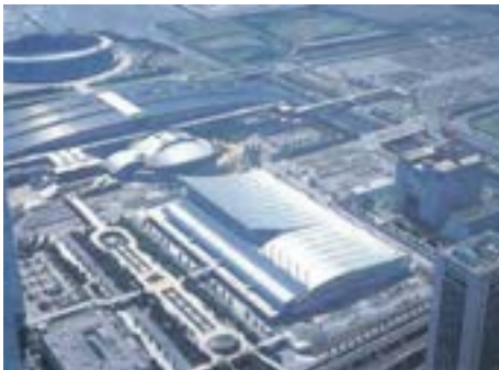
日本コンベンションセンター国際展示場9～11ホール(景観)
