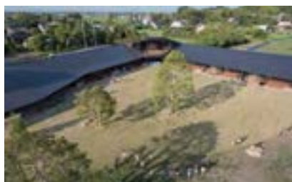
一宮どろんこ保育園 (一般建築物/入賞) 撮影／小川 重雄 建築主：社会福祉法人どろんこ会 設計：ユニップデザイン株式会社 施工：片岡工業株式会社 所在地：長生郡一宮町一宮8683
