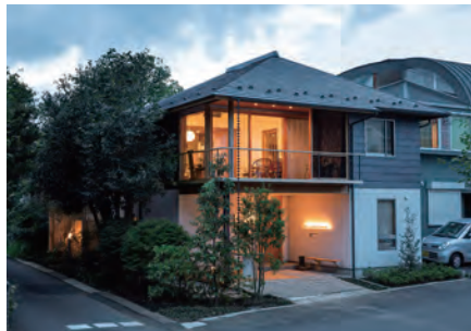
北面外観全景
