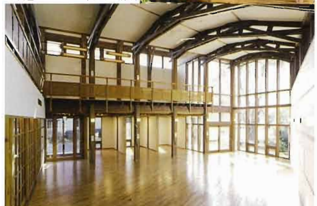
▼木造トラスと貫構法の構成
