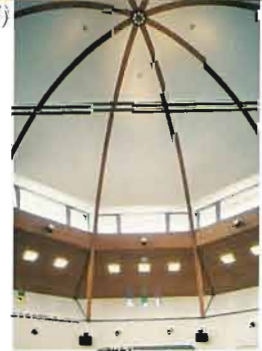
◀木の集成材を用いた遊戯室のドーム天井
