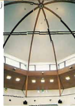
◀木の集成材を用いた遊戯室のドーム天井
