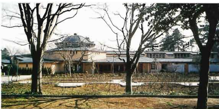
▲アプローチからの全景 (撮影 新写真工房)
