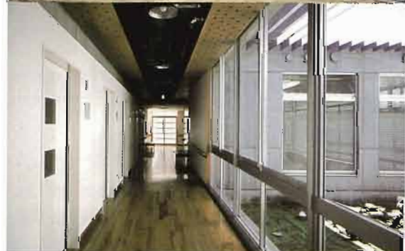
◀ 明るく開放的な共用空間の創出
