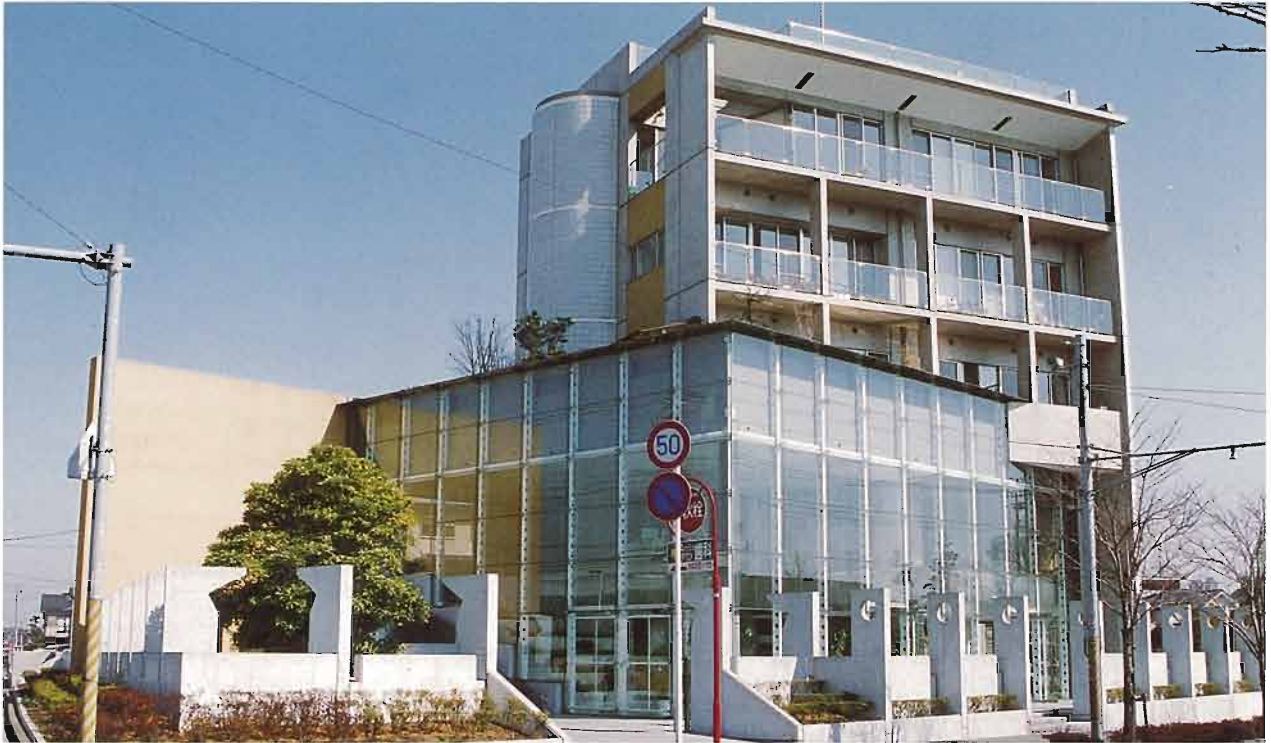
木の緑が映える全景（バイパス側から）
