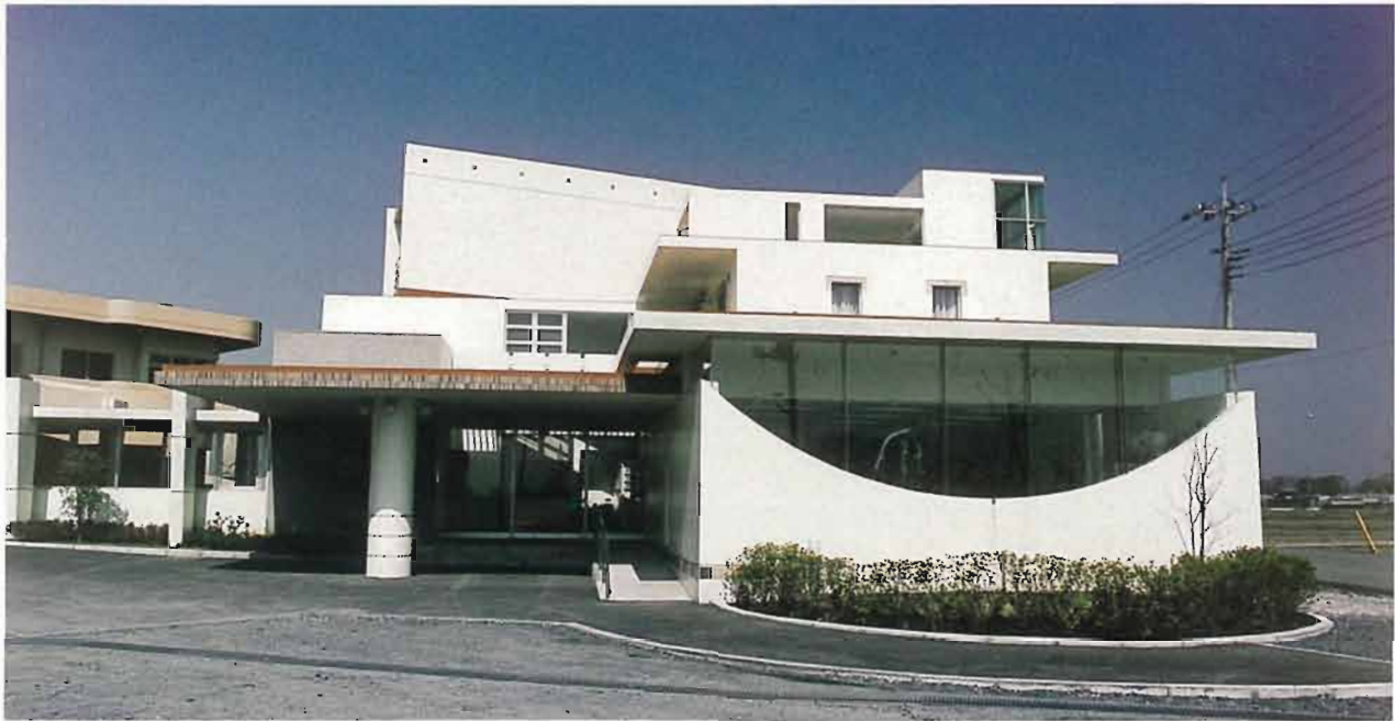
ひさしの大きな正面玄関アプローチ
