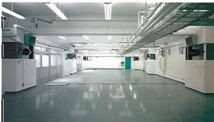
免震装置の設置 (提供：大成建設)
