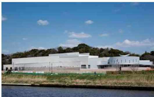
外観 新川側からの全景(新川とともに)
