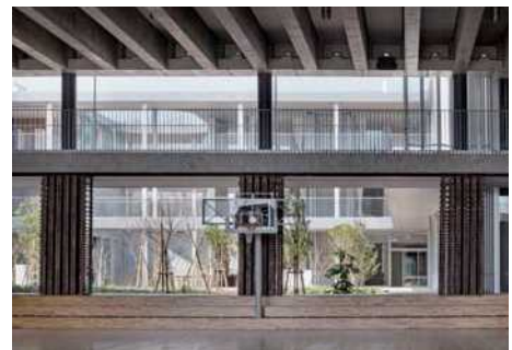
第一体育館より森のにわを見る 折戸を間口いっぱい開けることで風が抜ける
