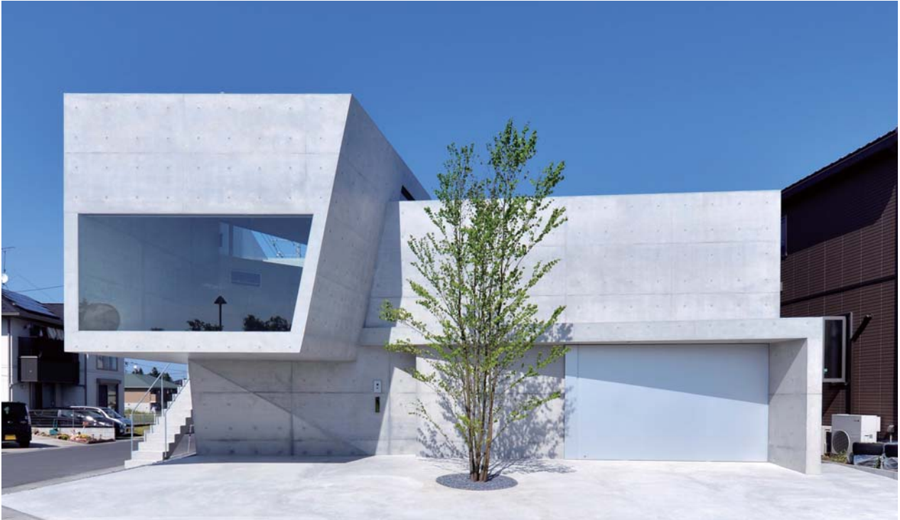
公園から見る南外観
