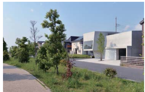
公園から見る南外観
