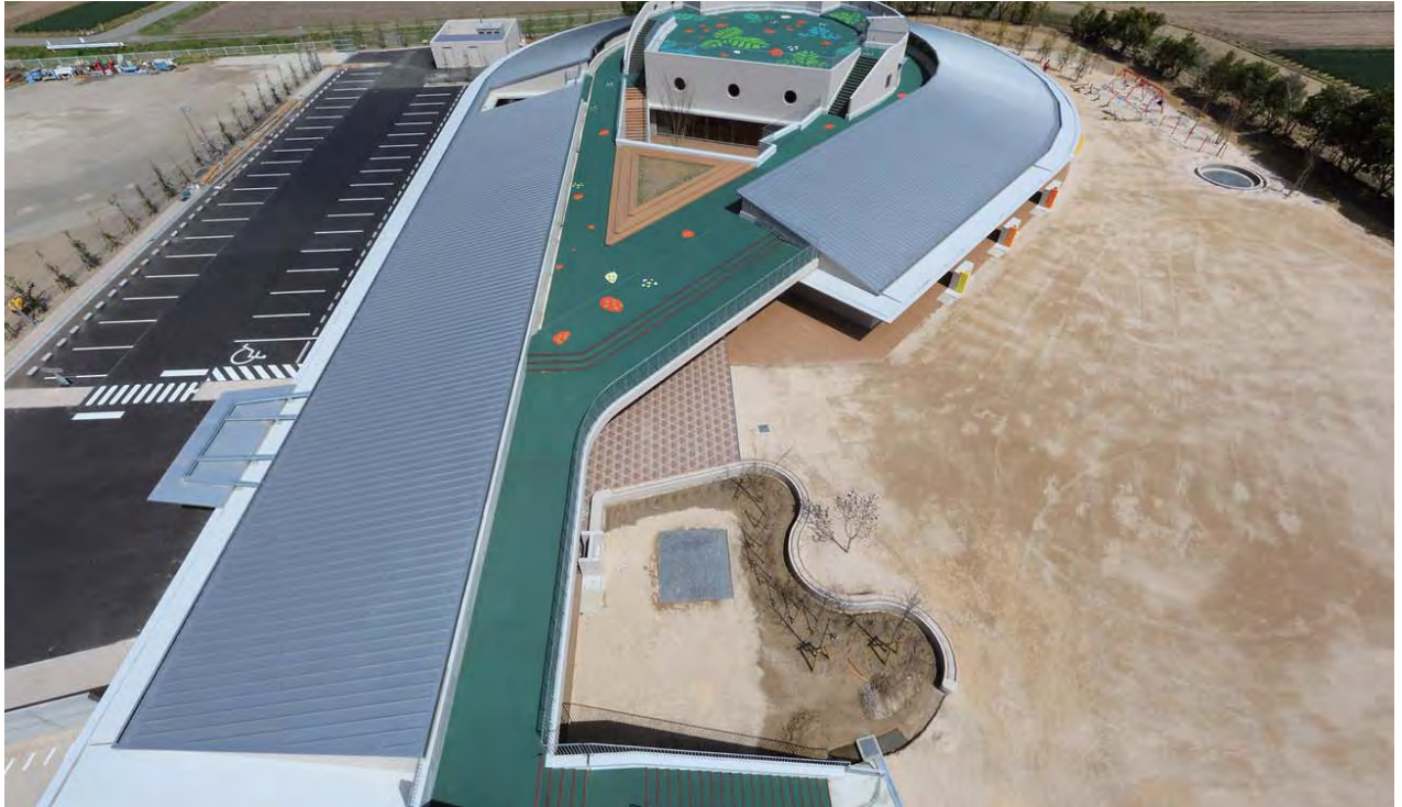
全景俯瞰 園舎中央の屋上広場が津波避難スペースとなる
