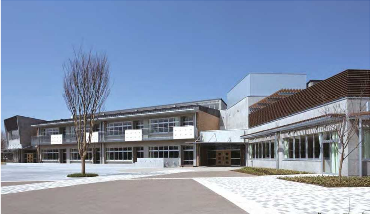
住宅地のスケールに合わせ連続する壁面を分節することで周囲への圧迫感を軽減した落ち着いた外観
