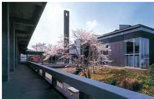
既存棟バルコニーから増築棟を見る
