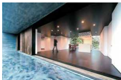
墨入モルタル表面に張られた水幕(庇下内観)
