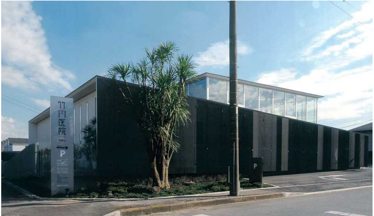
外観 住宅街の街並みに同行する木造2階建てのスケール
