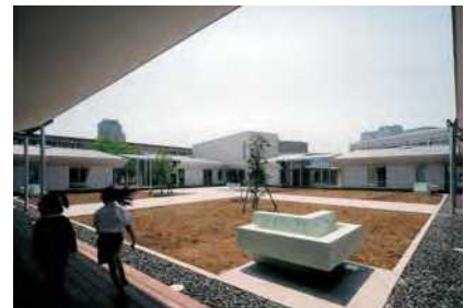
中庭の様子。内外一体的に利用できる庇下の縁側のような空間。
