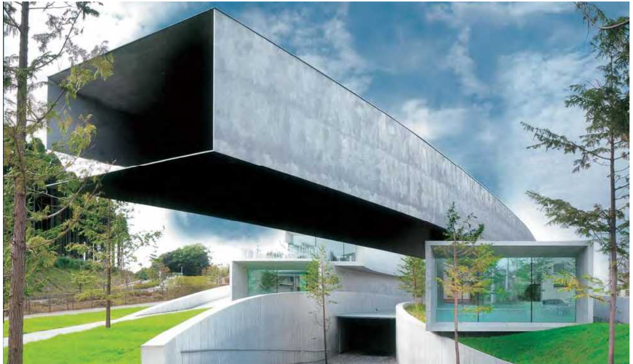
鋼板構造のギャラリーが30mのキャンチレバーで浮遊する(東側外観)
