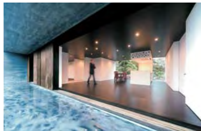
墨入モルタル表面に張られた水幕(庇下内観)
