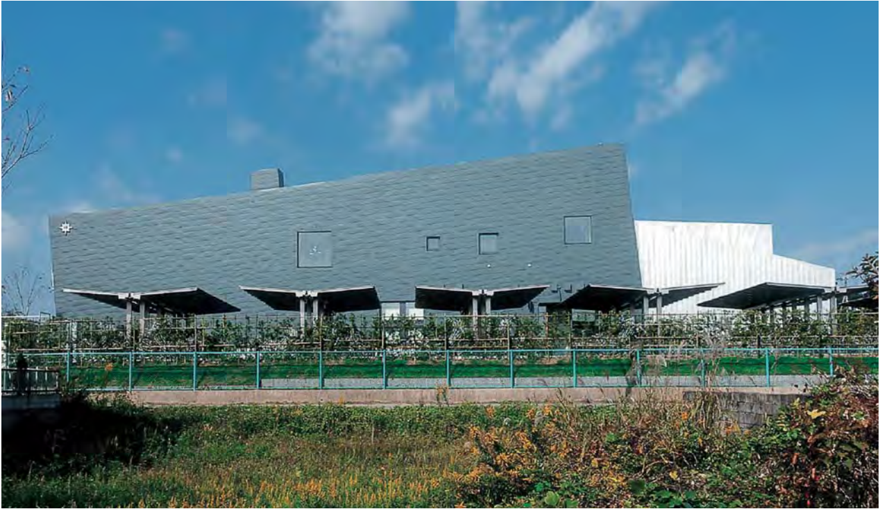
片流屋根と熱負荷を考慮し限定した開口部、集熱効果を高める色彩が特徴的な東側外観
