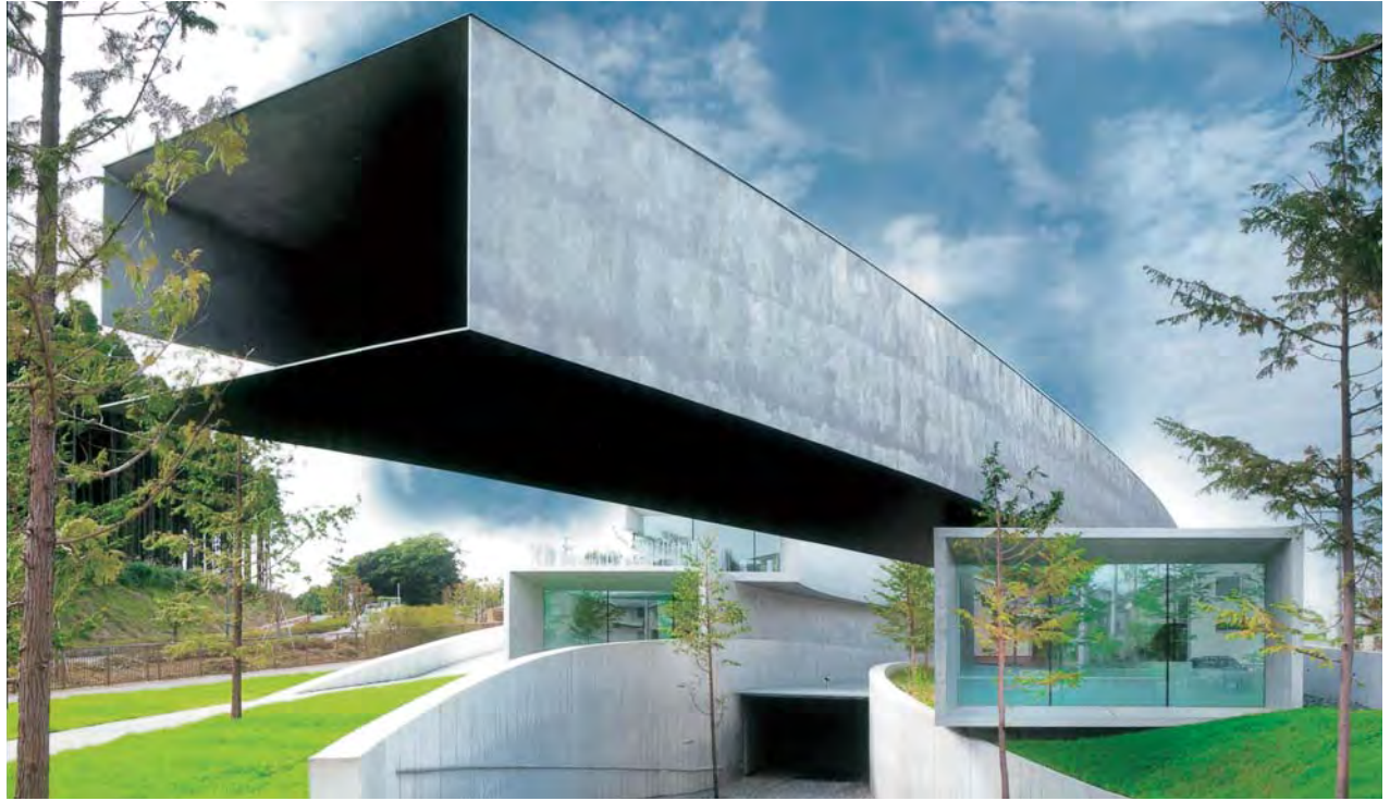
鋼板構造のギャラリーが30mのキャンチレバーで浮遊する(東側外観)
