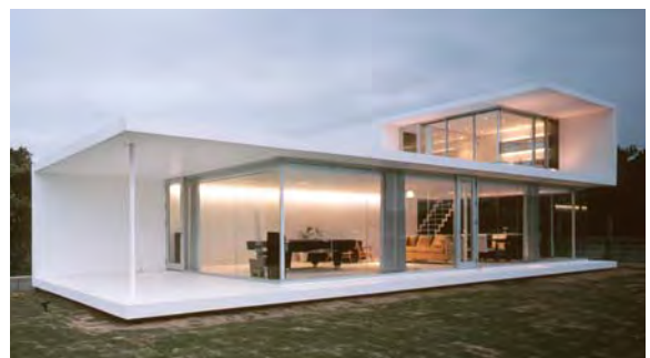
南西から建物を見る
