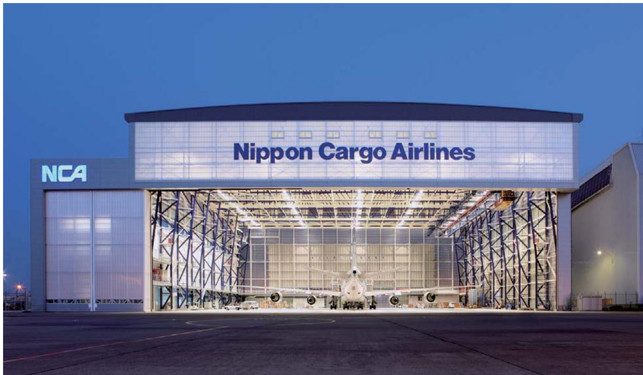
正面より格納庫内を見る(夕景)
