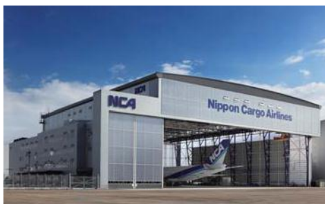
エプロン側全景(大扉開放)
