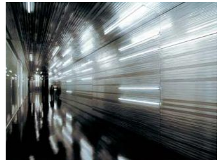
2種類のLGS素地を積層し、下地材を仕上げ材に転用した通路
