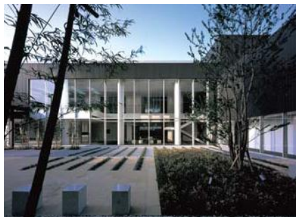
中庭より研修棟を見る
