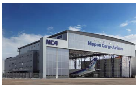
エプロン側全景(大扉開放)
