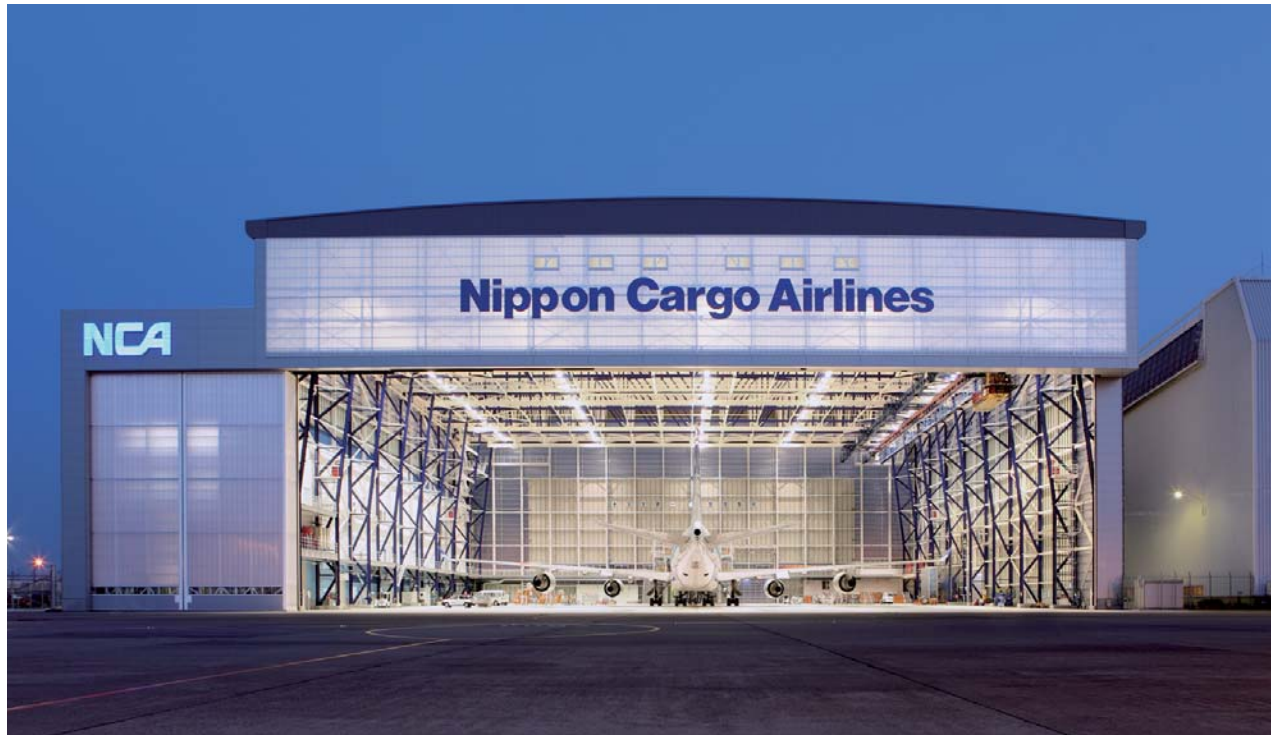
正面より格納庫内を見る(夕景)
