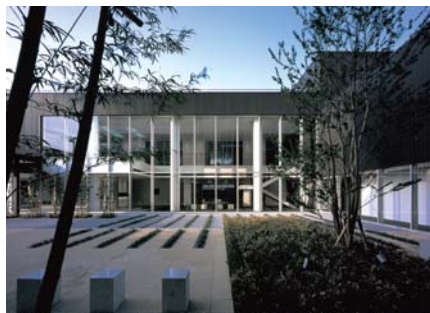
中庭より研修棟を見る
