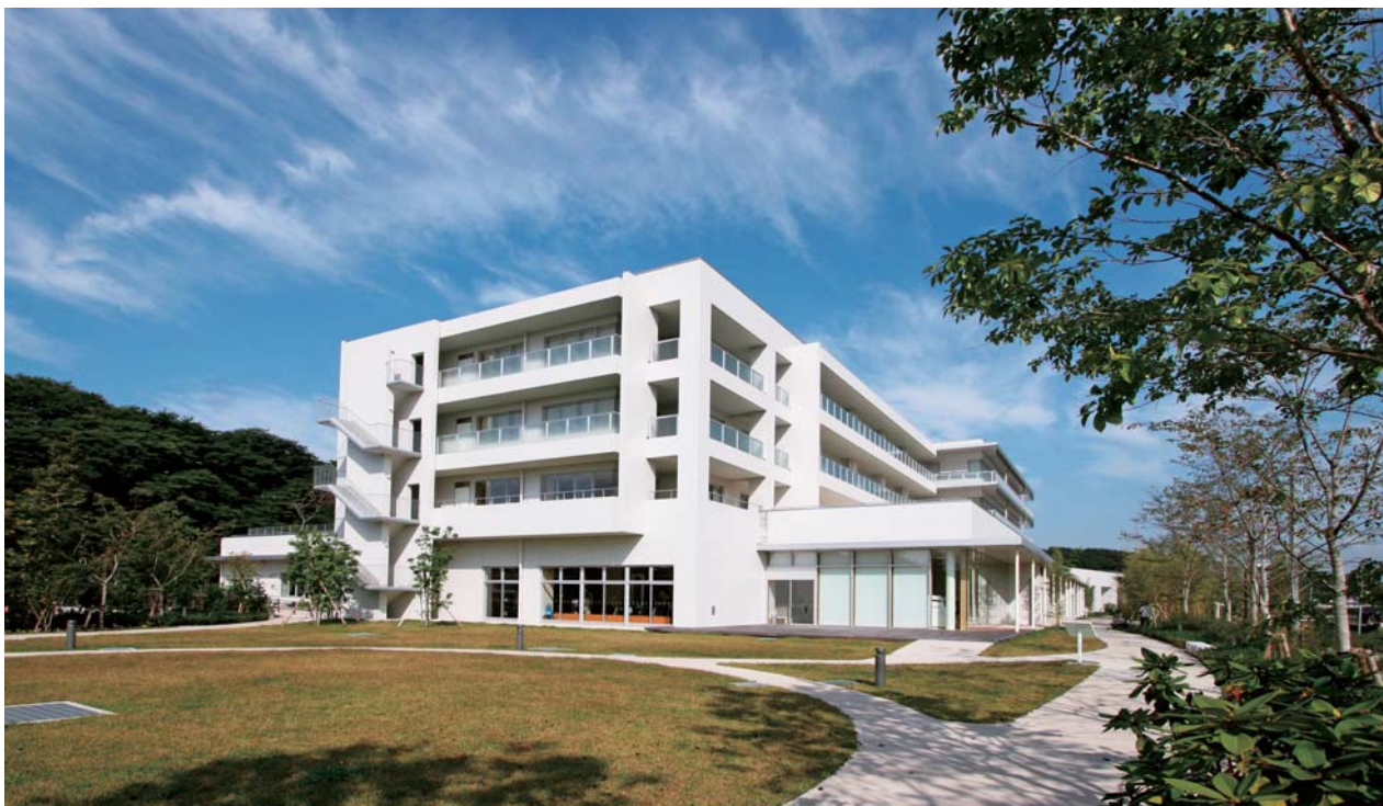
東側外観 遊歩道より望む
