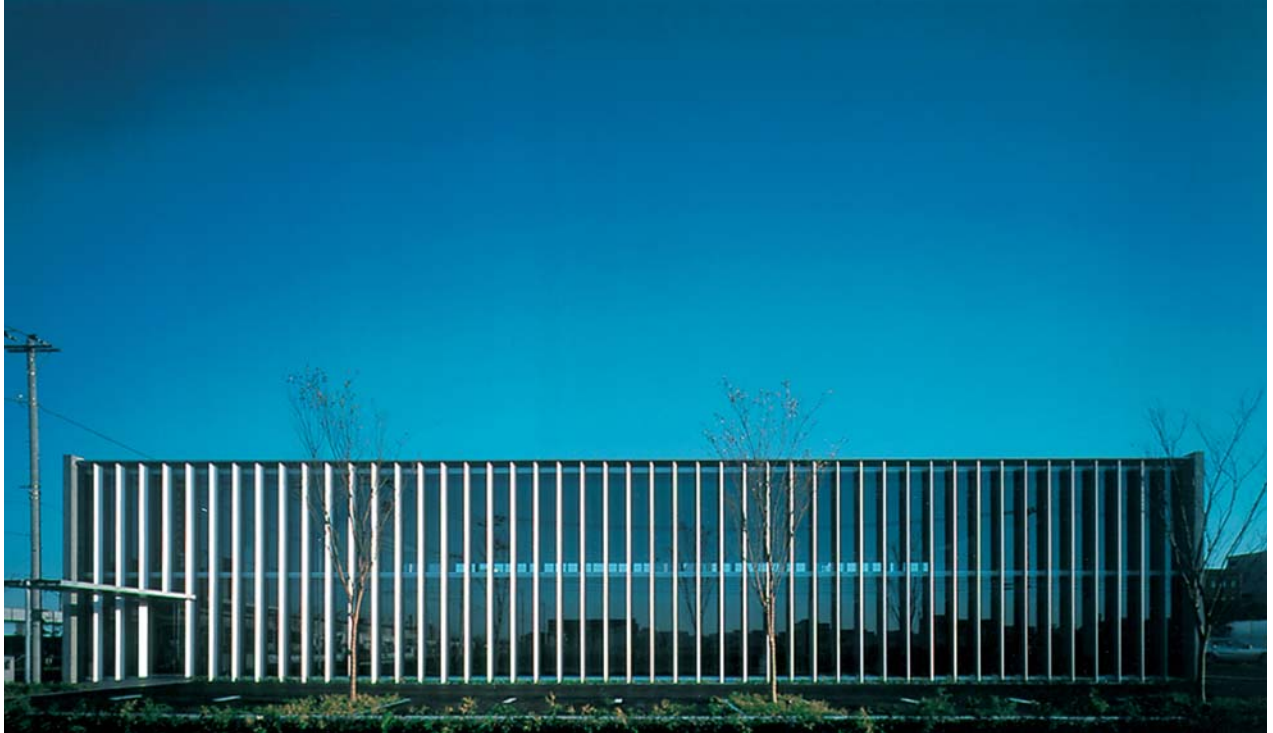
透明感あるシンプルでエレガントなファサード
