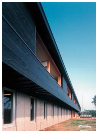
前庭からの外観
