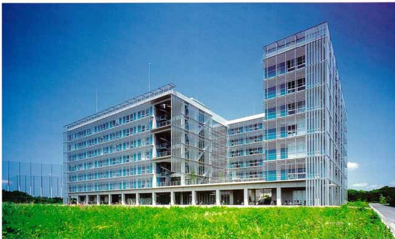
方位毎に変えたルーバーと金属断熱サンドイッチパネルの織りなす外観
