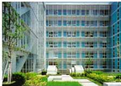
金属断熱サンドイッチパネルはアルミサッシ固定。講堂上部は屋上緑化
