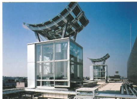
ソーラーチムニー頂部
