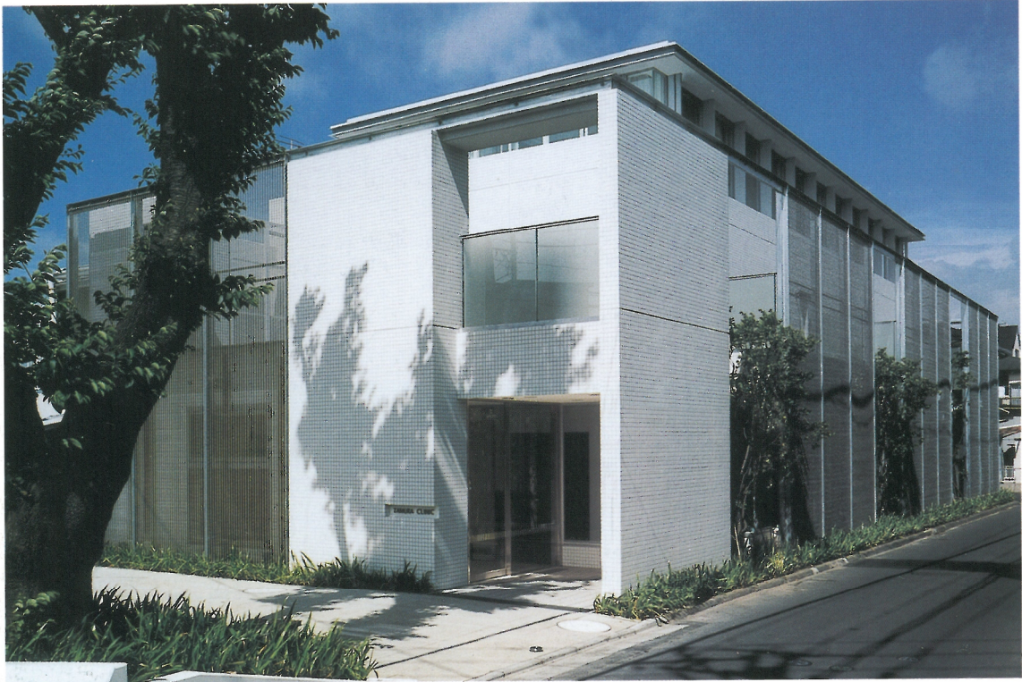
診療所エントランス側からの外観
