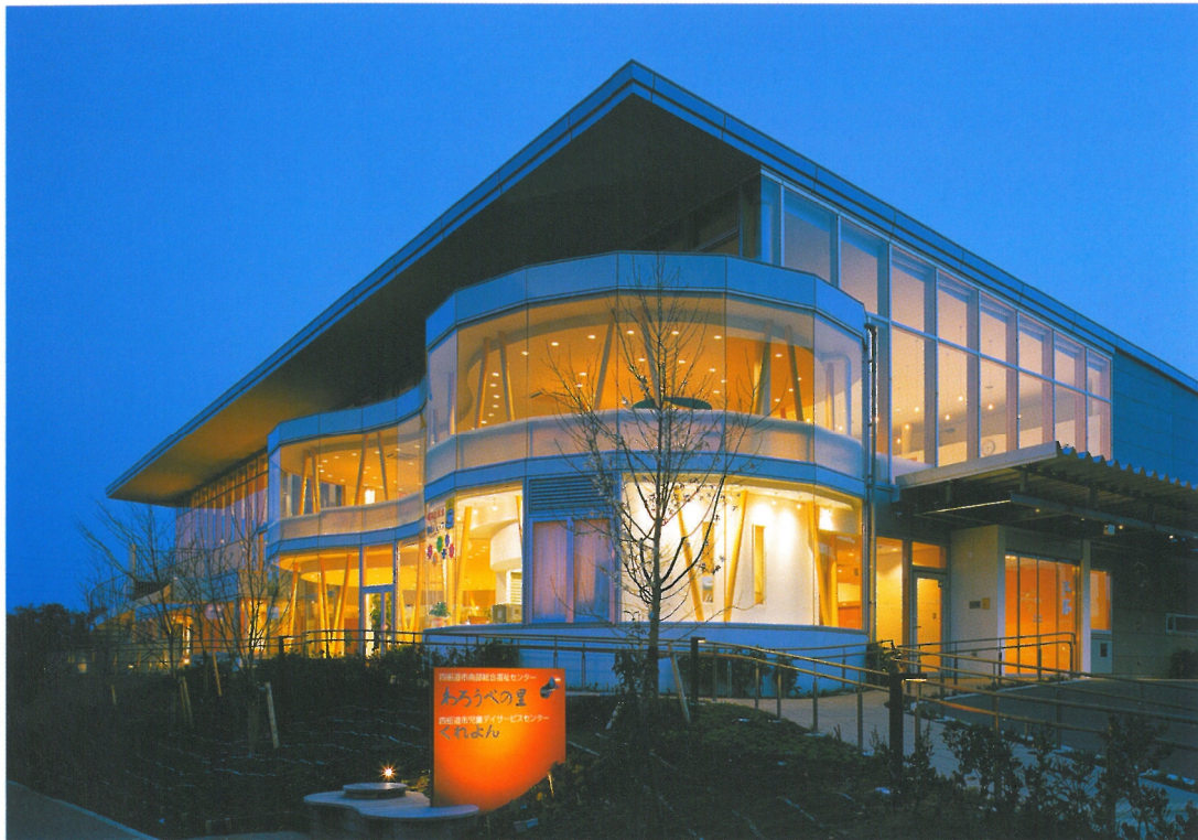
正面玄関側からの外観
