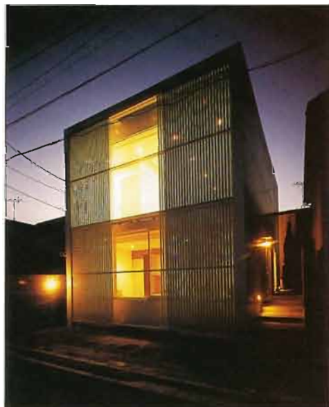
南側全景（夕景）
