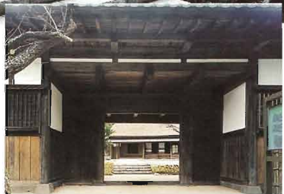
門の奥に浮かぶ母屋全景
