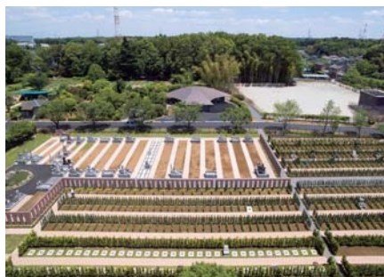
西側から礼拝堂と霊園全体を見る
