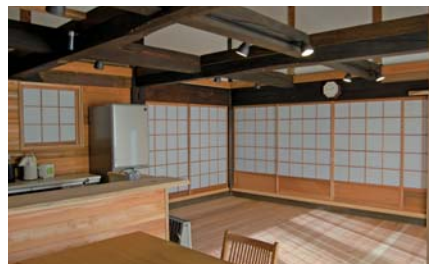
元土間をLDKに改修 中2階を取り払い吹き抜けに改修
