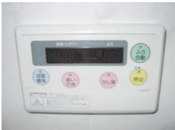
浴室給湯器のコントロールパネル。基本の操作ボタンが大きく表示され、使用方法が、わかりやすくなっています。細部の調整は、蓋つきの部分に収納されています。
